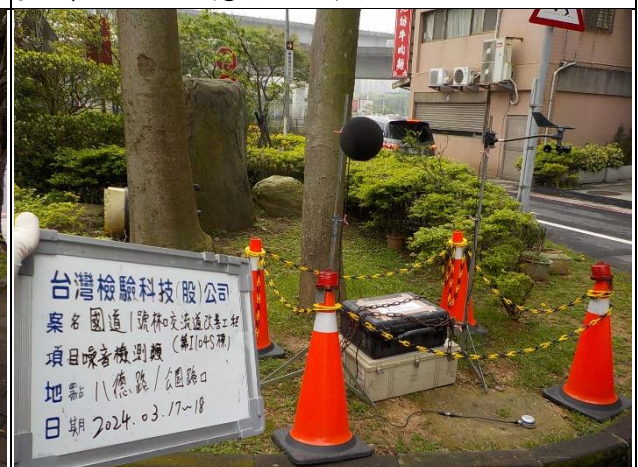
監測項目：環境噪音振動 監測日期：2024.03.17~18 監測地點：八德路/公園路口
